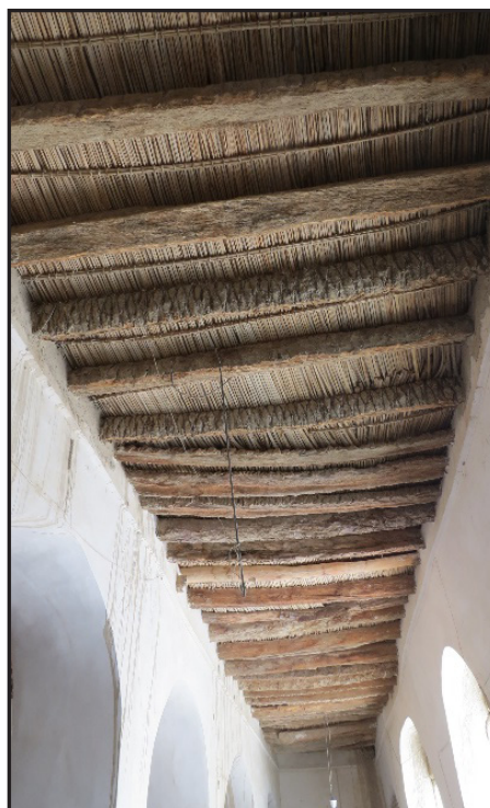
تصویر ۷. پوشش سقف مسجد جامع دزک در شبستان شمالی. همان-طور که مشاهده می‌شود نحوه اجرای سقف در این شبستان نسبت به بخش‌های قدیمی‌تر، ساده‌تر است (عکس از: نگارنده، ۱۳۹۴).
