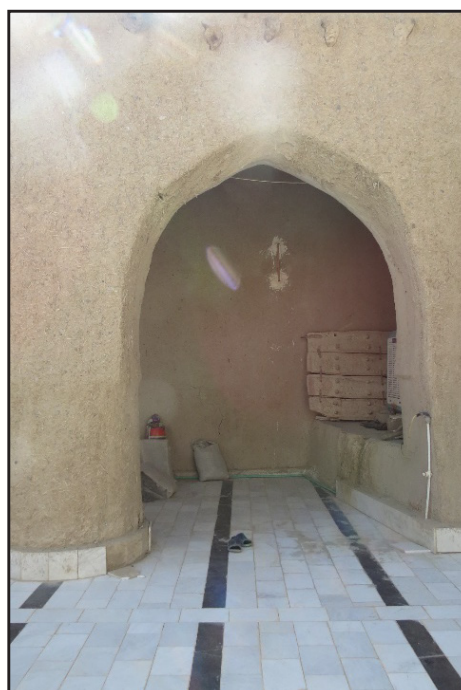
تصویر ۲۴. یکی از طاق‌های دهانه رواق شرقی؛ در این طاق سعی شده قوس مازهای به تیزه‌دار تبدیل شود (عکس از: نگارنده، ۱۳۹۴).
