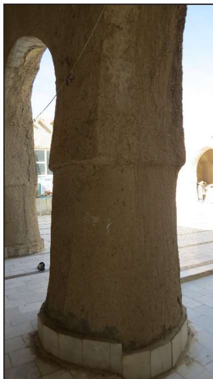
تصویر ۲۳. نحوه اتصال ستون و طاق در رواق شرقی (عکس از: نگارنده، ۱۳۹۴).
